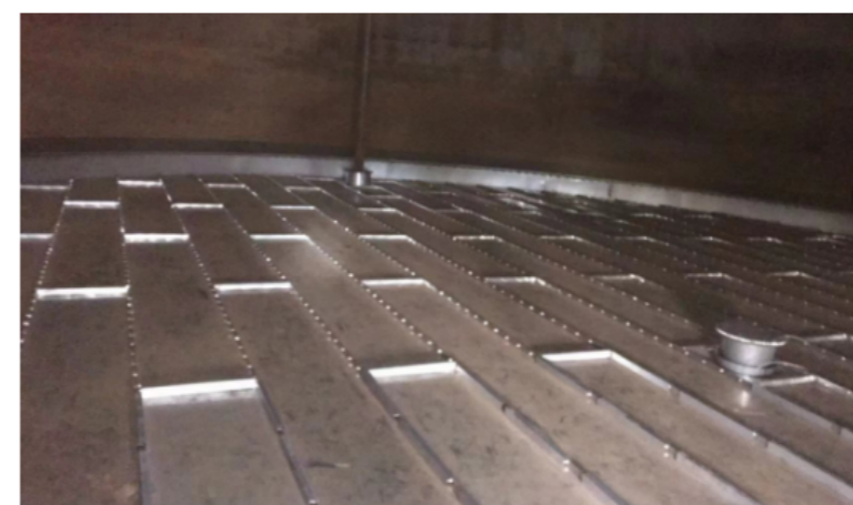
全接液蜂窝浮盘结构图
